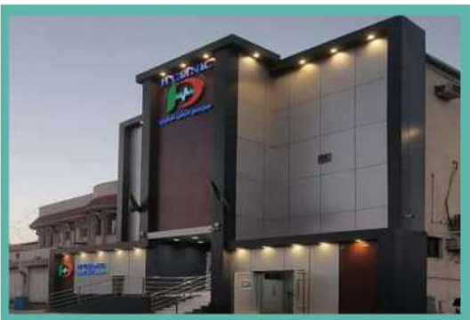
مبنى المستوصف عقار مؤجر
