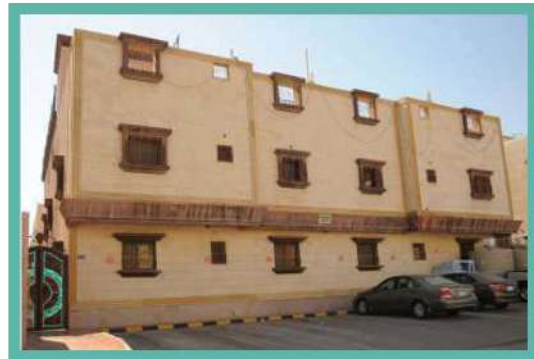
مبنى كافل 1 عقار مؤجر
